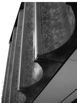
[그림 3] Nottingham Contemporary Art Centre의 외벽 콘크리트 패널의 레이즈 패턴
